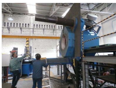
工業炉据付後試運転立会
