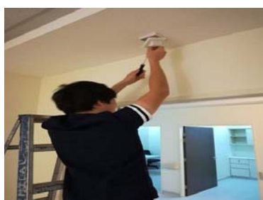
顧客施設における製品設置作業のサポート
