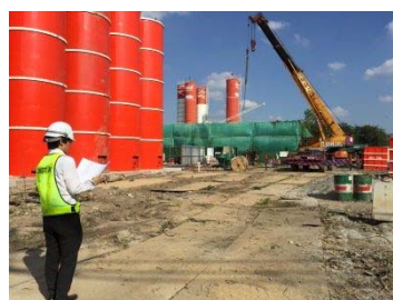
地下鉄建設現場視察状況
