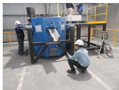
工業炉据付工事立会
