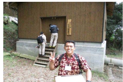
白糸の滝でマイクロ水力発電所の部品の一部をメンテナンス
