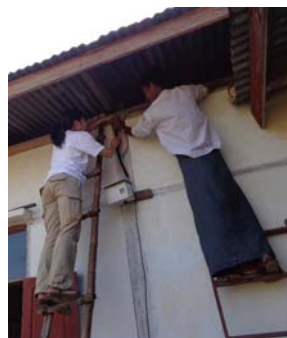
モニタリングカメラの設置検討風景
