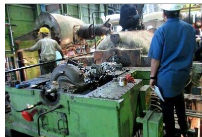
シャットダウン作業
