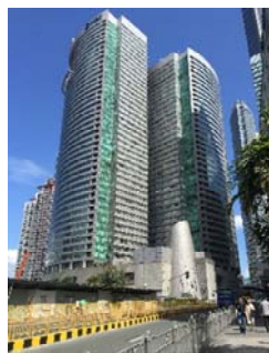
オフィスが入るビル (RCBC plaza)
