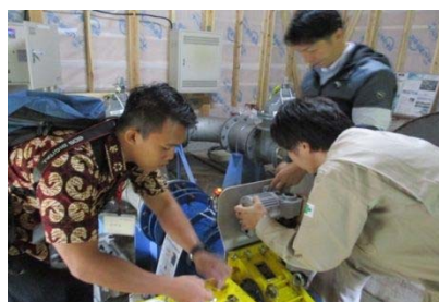
冬季の流水量を制御する 自動回転装置の設置
