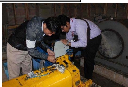
白糸の滝マイクロ水力発電所を改良する作業を実施
