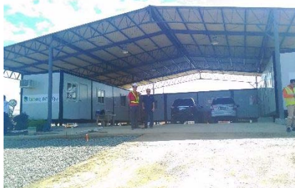
さとうきび・バイオエタノール収穫所の建設現場
