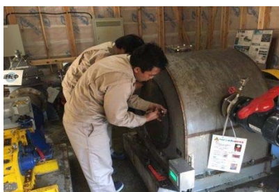
タービンのバケットのメンテナンスと 厚さのチェック
