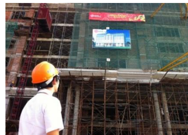
建設中の大学を視察し、関係者から話を聞く
