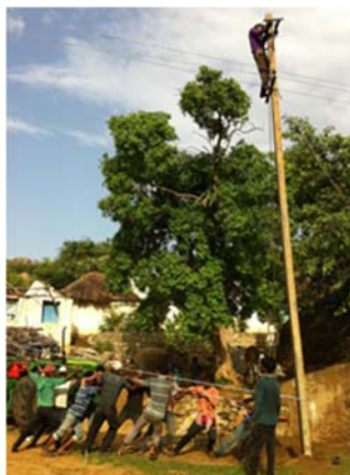
夏季休暇時に配電線工事を見学（インド）
