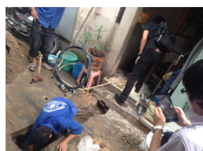
(視察) 漏水現場にて検知や補修の現状を学ぶ
