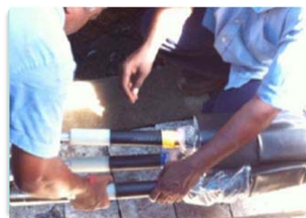
ケーブル不良箇所取替え工事の見学
