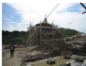
貯水池建設現場
