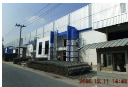
現在建設中の工場地の視察。
