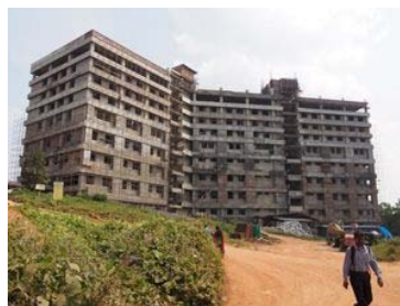
建設途中の現場全体像
