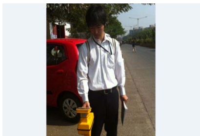
故障復旧作業風景。地中ケーブルの位置を探索し、掘削地点を決定する。
