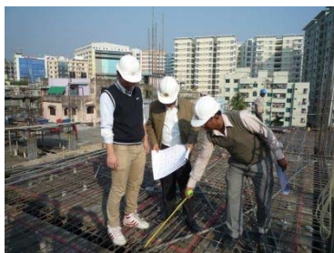
床スラブの配筋チェック
