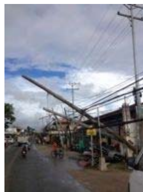
台風で被災したバンタヤン島の被害状況
