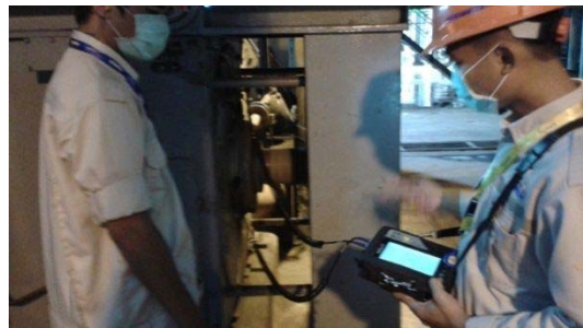
現場での作業
