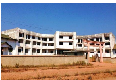
受入機関の外観
