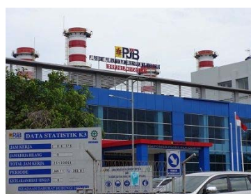
ジャカルタの発電設備視察時
