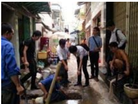
配管修繕の工事現場見学
