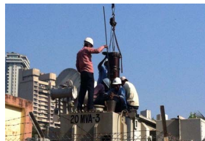
メンテナンス作業風景。装置の部品をクレーンで吊上げ、洗浄。
