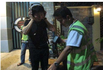
深夜給水配管の漏水探知
