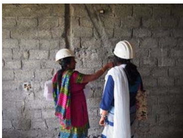
現場視察（施工精度のチェック）
