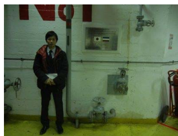
日本の無償援助事業の対象であったBajina Bašta水力発電所。
