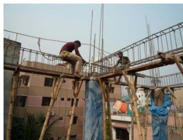
RC柱養生及び梁鉄筋作成風景
