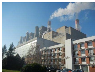
JICAの円借款事業の対象となっているニコラ・テスラA火力発電所。
