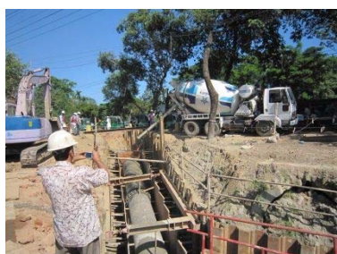
水道管敷設工事現場
