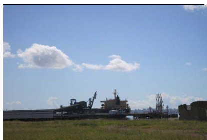
石油製品タンクターミナル遠景 (2014年2月)
