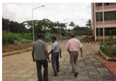
主席技師に同行し、オフィス建設現場の見学。周辺道路敷設に関する留意事項などを伺った。
