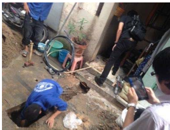
配水管のリーク補修現場
