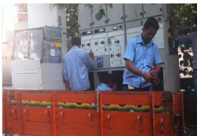
リプレース作業風景。トラック上で試験実施後、変電所へ搬入。
