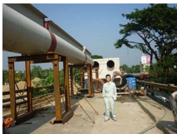
水管橋建設現場見学
