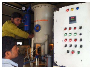
変圧器内オイル取替工事の見学
