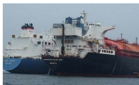
ジャカルタ沖15kmにある浮体式LNG受入基地 視察時
