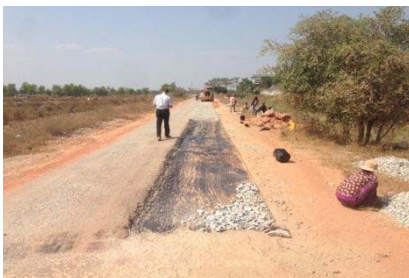
道路工事の現場見学
