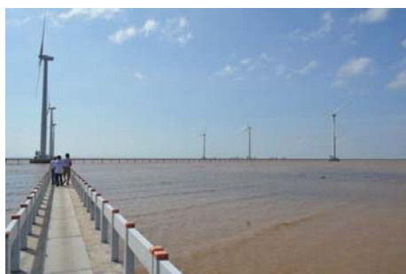
Bac Lieu省洋上風力発電所 (GE製1.6MW x 10機)
