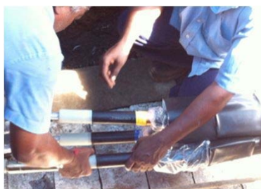
ケーブル不良箇所取替工事の視察
