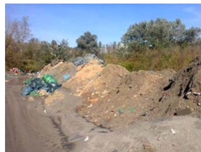
ニコラテスラA 排水処理工場予定地
