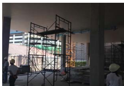
作業状況の確認
