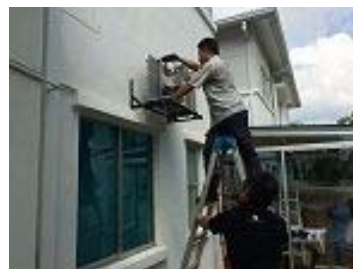
エアコン修理の様子
