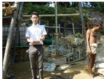
低所得者層向けの深井戸の建設現場
