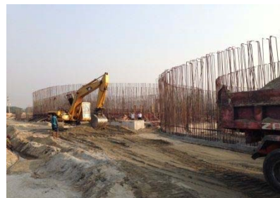
訪れた建設中の政府系工業団地の現場
