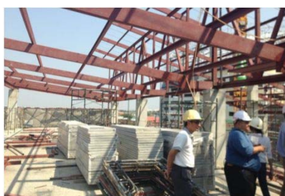
建設現場の視察
