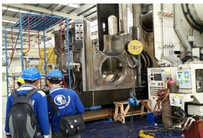
工場設備の工事現場
