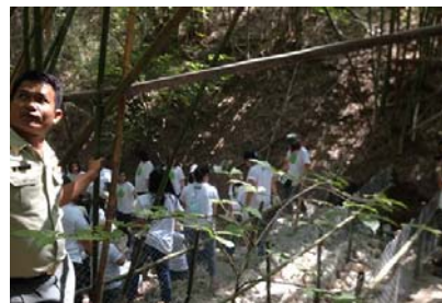
社員研修でのミニダム建設風景
