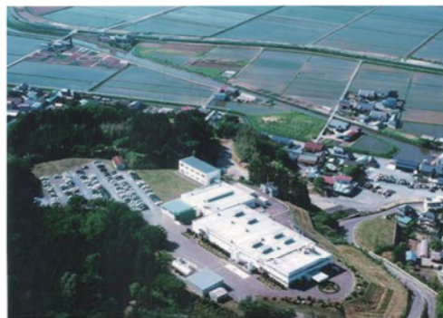
河北ライティングソリューションズ株式会社 本社工場
